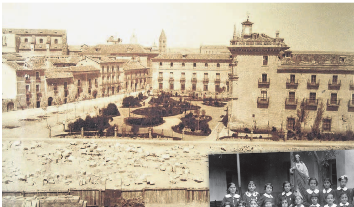
Instantánea de 1883 que muestra el Colegio al fondo, la Plaza de Santa Cruz y el Colegio de San José en construcción.
